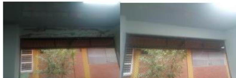
RESANE, ESTUCO Y PINTURA EN HUMEDAD DE AULA DE SISTEMAS.
