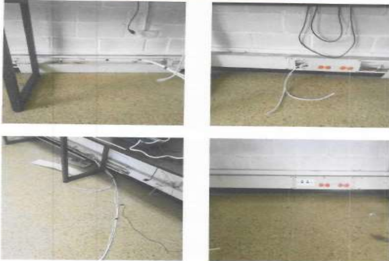
INSTALANDO CABLEADO NUEVO EN CANALETA.
